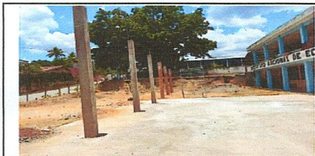
Foto 3: MEJORAMIENTO CON LOSA DE PATIO Y SU ESTRUCTURA DE TECHO.
