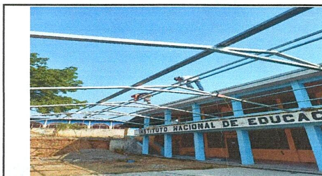
Foto 5 y 6: ESTRUCTURA DE TECHO: Proceso de la colocación de estructura de techo en el espacio asignado.
