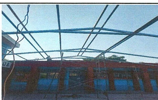
Foto 5 y 6: ESTRUCTURA DE TECHO: Proceso de la colocación de estructura de techo en el espacio asignado.
